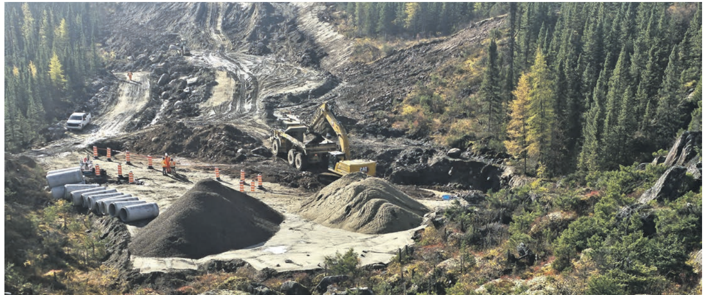
En 2023, une partie des travaux ont été effectués sur la route 389 entre Fire Lake et Fermont. Photo MTMD
